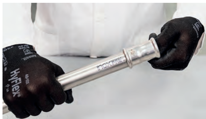
Fig. 36 – Införing av röret i presskopplingen
