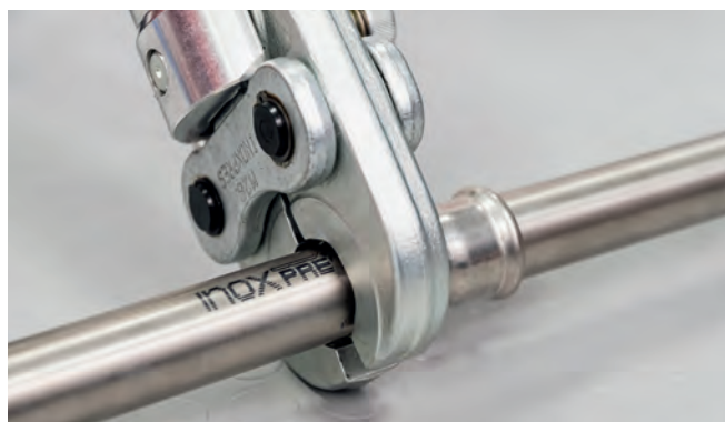
Fig. 37 – Utförande av pressanslutningen
