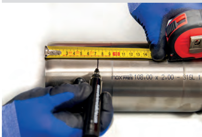
Fig. 28 – Markering av införingsdjupet med hjälp av ett måttband
